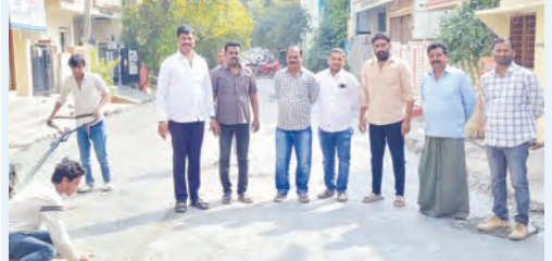
సి.సి. రోడ్డు పనులను పరిశీలిస్తున్న కార్పొరేటర్ లచ్చిరెడ్డి
